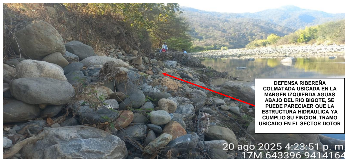
FIGURA N°02: TRAMO CRÍTICO EN EL RIO BIGOTE MARGEN IZQUIERDA AGUAS ABAJO EN EL SECTOR DOTOR, EN LA CUAL LA ESTRUCTURA HIDRAULICA SUMPLIO SU FUNCION Y EL AREA SE ENCUENTRA COLMATADA AFECTANDO TIERRAS AGRICOLAS Y POBLACION, DISTRITO DE SAN JUAN DE BIGOTE, PROVINCIA DE
